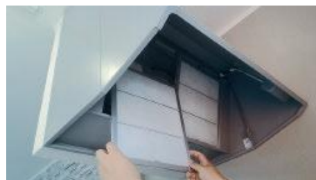
レンジフードフィルター
